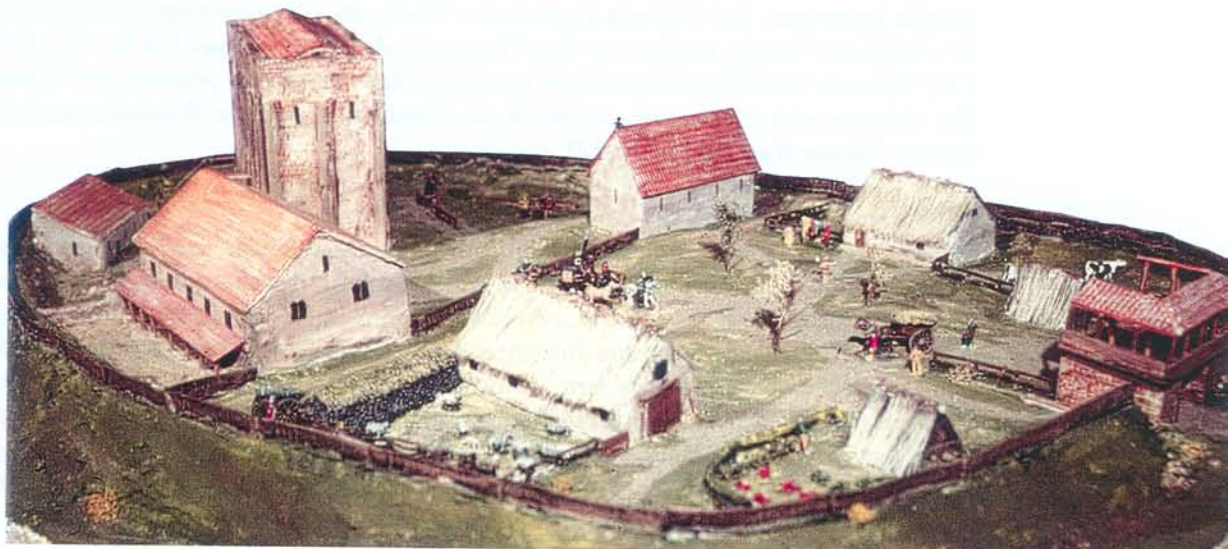
Premier état du château de la Madeleine à Chevreuse.
