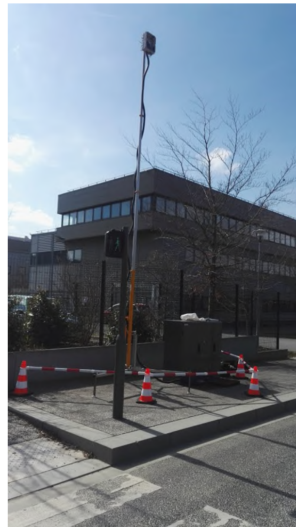
UBR installée sur carrefour 42 de EVAPS (Thalès)
