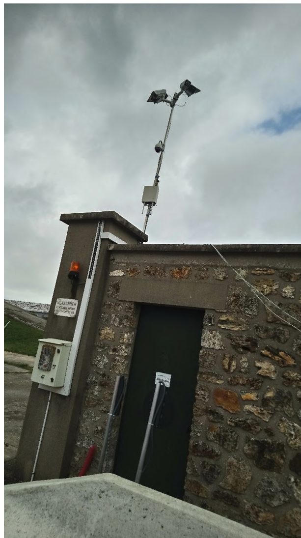
1 UBR et plusieurs caméras sur mât bord de piste Satory
