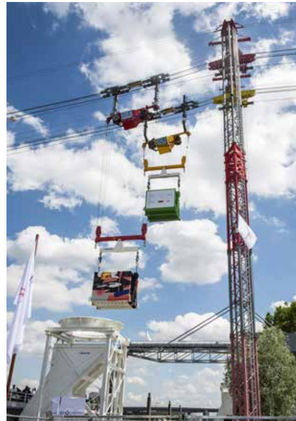
Clichy, Quartier du Bac Inédit, un dispositif totalement innovant : un téléphérique pour transporter des milliers de tonnes de terre excavées directement vers la Seine, des norias de camions évitées pour les riverains (80 camions par jour pendant 6 mois).
