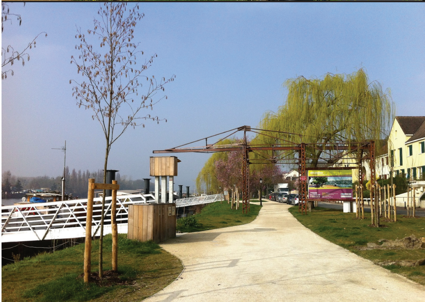
RESTAURATION DES BERGES À CONFLANS SAINTE-HONORINE (78) après l'intervention du SMSO
