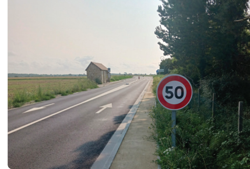
Réaménagement du carrefour le Romainville RD 195 à Magny-les-Hameaux
