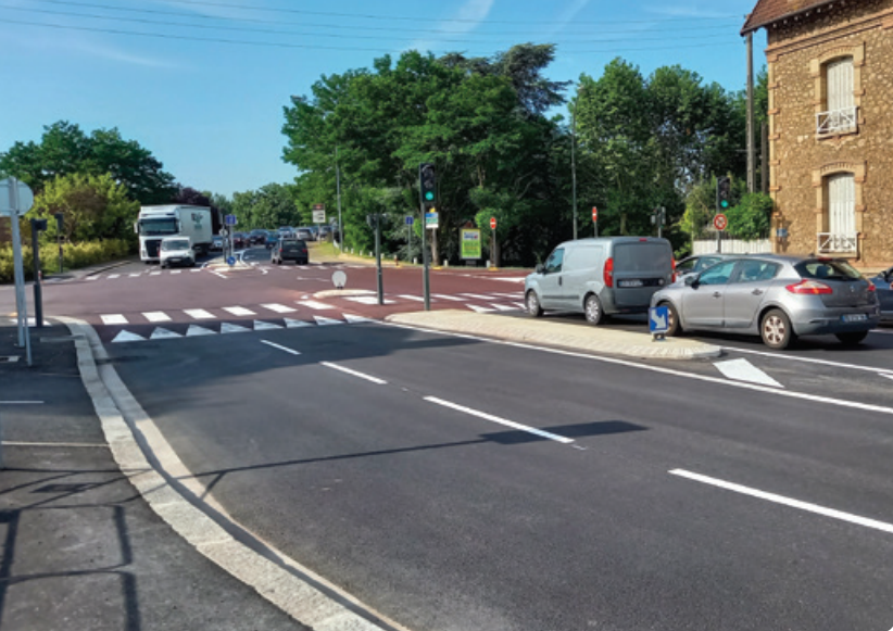
Travaux sur le carrefour RD14/Quai Albert JOLY à Meulan-en Yvelines
